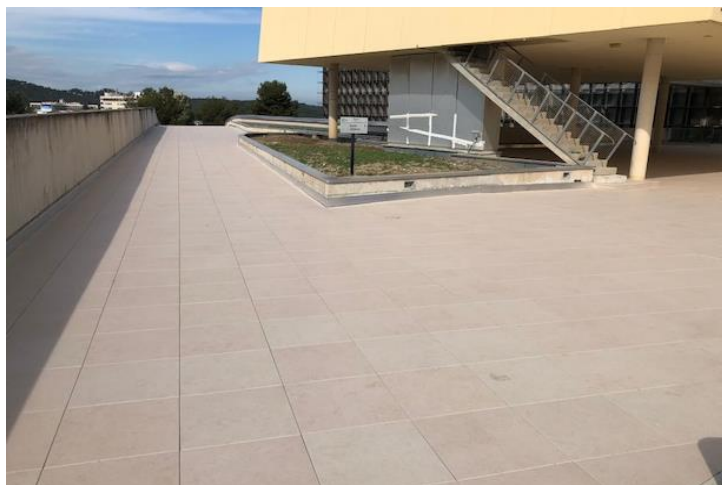
Bâtiment INMED Luminy (898m 2 )- INSERM TERRASSE ACCESSIBLE DALLE CARRELAGE
