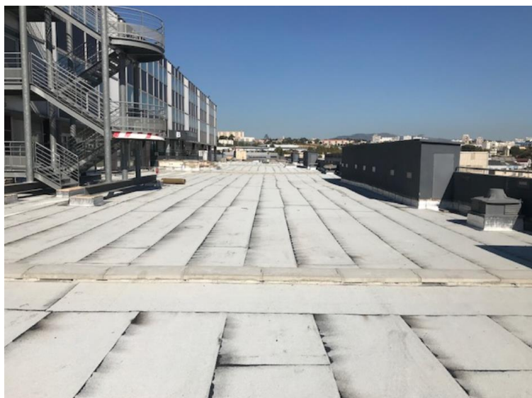
Parking Gay Lussac Marseille 14 ème 15000m 2 TERRASSE ACCESSIBLE ETANCHEITE SOUS ENROBE
