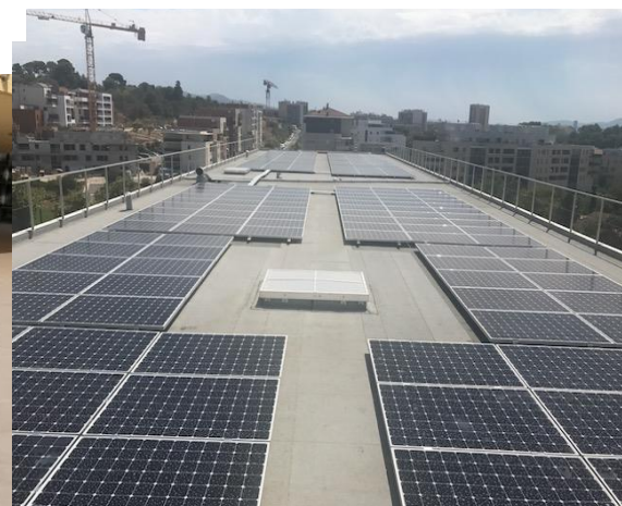
GS MIRABILIS (2200m 2 ) TERRASSE INACCESSIBLE SOUS PANNEAUX PHOTOVOLTAIQUE
